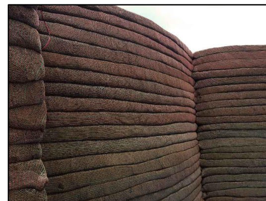
Muro de arrimo_hiper adobe
