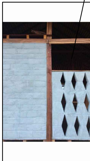
Parede sementeira_tijolo de adobe estilo africano
